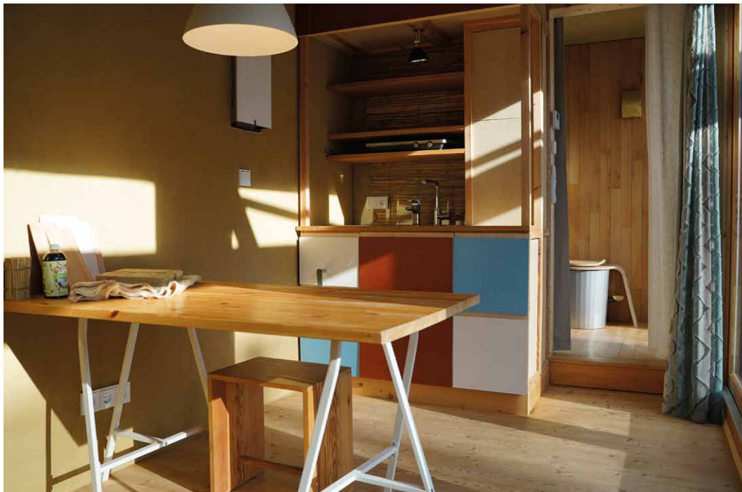
↑ Abb. 2. Der Innenraum des Zero Waste Space ist als voll ausgestattete, autonome Arbeits- und Wohneinheit konzipiert. Im Bereich der Küche wurde ein rückbaubares Küchensystem, bestehend aus einer Holzkonstruktion mit Stroh-Hanfplatten, getestet. Foto: Tanja Lücker.
