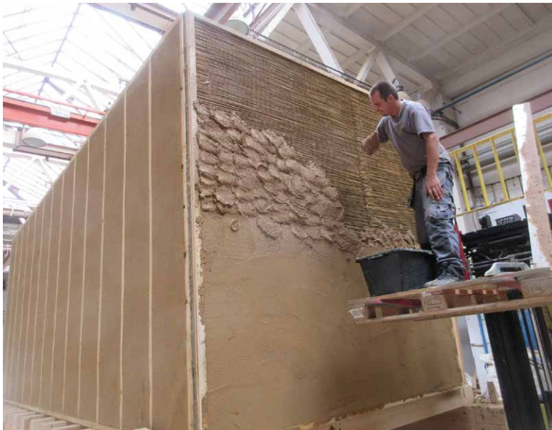
← Abb. 4. Die Wände des Zero Waste Space sind aus nachwachsenden Baustoffen mit guten klimatischen Eigenschaften gefertigt: Holz, Stroh, Flachsvlies und Lehm. Auf zusätzliche Kunststofffolien im Wandaufbau wurde verzichtet. Foto: Roland Meingast.
