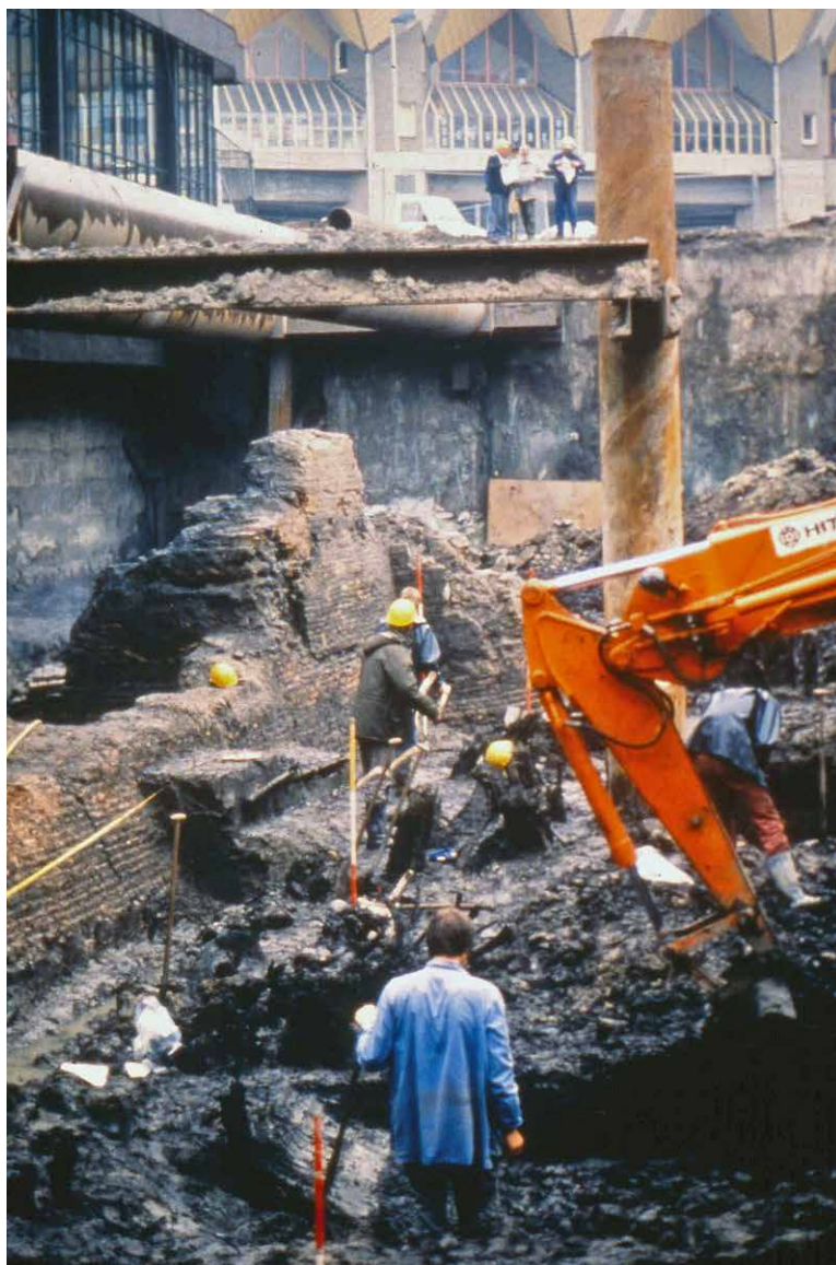
De opgraving in het tracé van de Rotterdamse (Willems)spoorntunnel, eind jaren tachtig, was een voorbeeld van deels extern gefinancierd, grootschalig onderzoek in de binnenstad. Het werd in die dagen nog volledig uitgevoerd door de plaatselijke archeologische dienst, die in de Maasstad een relatief sterke positie had in de gemeentelijke organisatie (foto: Archeologie Rotterdam).
