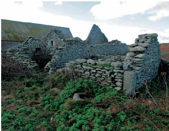
Fig. 29 – L'exemple de la ferme insulaire de Béniguet, abandonnée en 1954, suffit à illustrer l'état de ruine de bâtiments en pierres sèches au bout de deux ou trois générations (crèche, grange, four). Les dernières assises des murs et des pignons sont généralement éboulées et certains pans de mur sont entièrement effondrés (ci-dessus).
