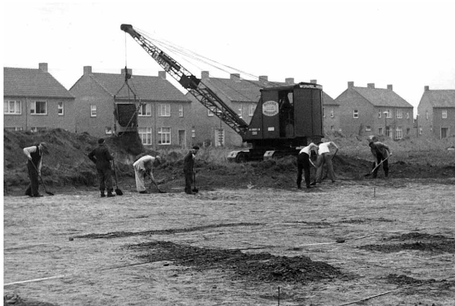
Figuur 4.13 Het gebruik van een graafmachine of 'bagger' om de bovengrond weg te graven tijdens het onderzoek in Elsloo in 1958. Aansluitend werd het vlak met batsen door loonarbeiders 'opgeschaafd'
