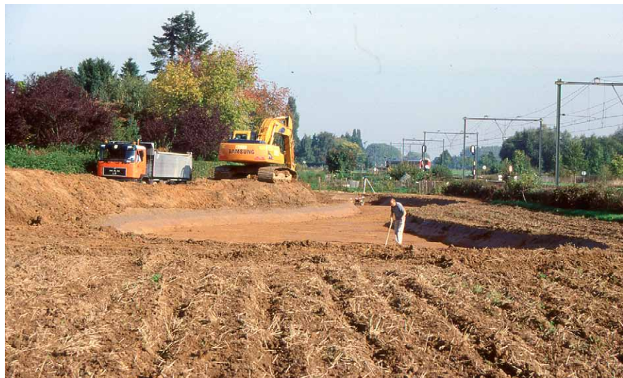
Figuur 5.10 Geleen-Seipgensstraat: de aanleg van het waterbassin; de bouwvoor en B-horizont zijn duidelijk in het vrijgegraven profiel zichtbaar (foto H. Vromen)
