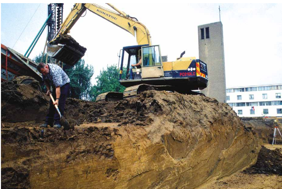
Figuur 13.2 Het begeleiden van de graafwerkzaamheden. Op de voorgrond H. Thomissen en op de achter- grond de Sint Christoffelkerk (foto gemeente Maastricht)
