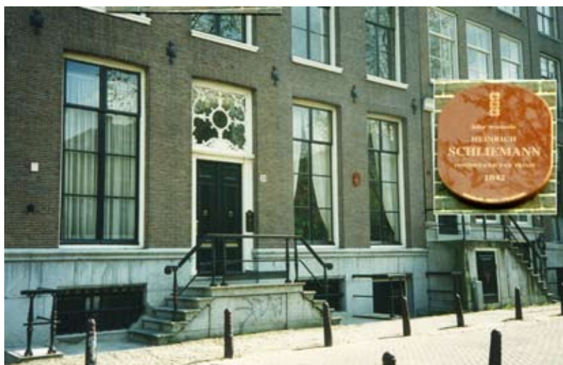
Hoyack & Co - Heerengracht 286. In tegenstelling tot wat er op het herinneringsbord staat heeft Schliemann hier nooit gewoond.
