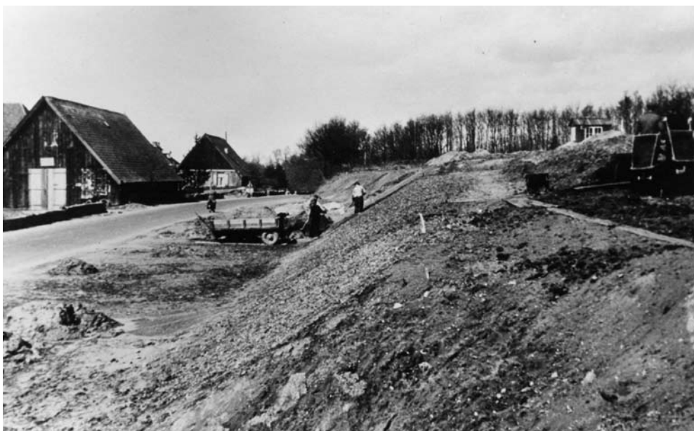
De helling van de Donderberg werd afgegraven om de weg (links) te kunnen verbreden. De graven lagen dicht onder het maaiveld en al bij de eerste 'happen' zand rolden er scherven naar beneden.
