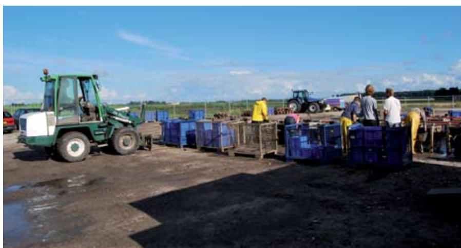
Fig.10: Kratten in gaasboxen in opslag naast de zeefinstallatie; N23.
