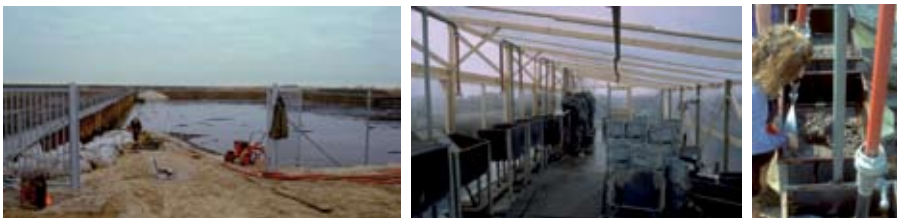
Fig. 1: In- en uitrit opgraafsterrein, zeefinstallatie en zeefmethode A27- Hoge Vaart.
