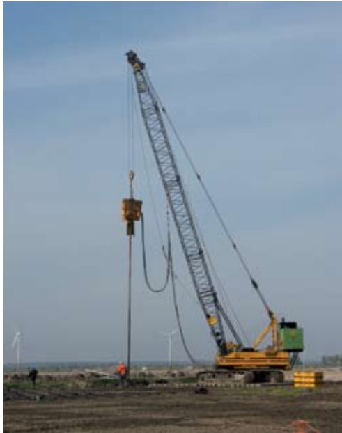
Fig. 5: Injecteren waterglas; N23.
