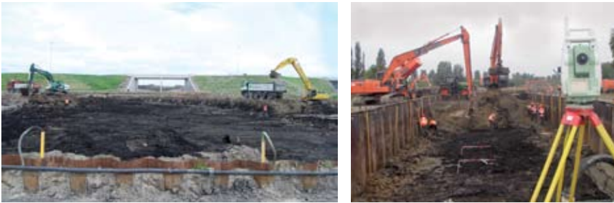
Fig. 6: Afgraven bovengrond; N23 & Sluiskil.
