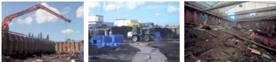
Fig. 7: Transport: Hijsen met kraan; Sluiskil, kleine shovel; N23 & portaalkraan; Polderweg.
