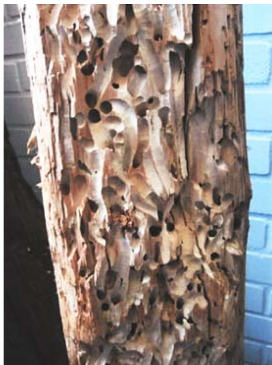
Fig. 2. Een door paalwormen doorknaagde paal (foto Hoogheemraadschap Hollands Noorderkwartier).
