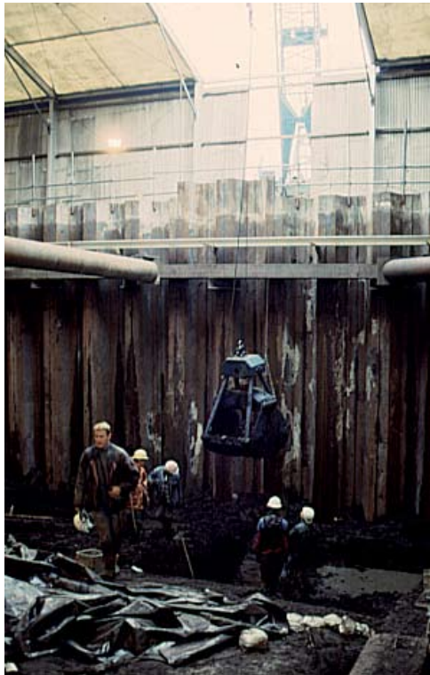
Fig. 3: Het afgraven van grond met een knijpbak; Polderweg.
