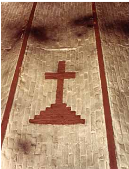
Voorbeeld van een ingemetseld kruis in het plafond van een paardenstal in Libeek
