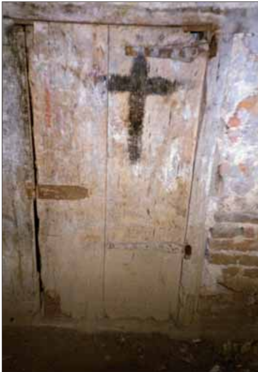
Voorbeeld van een ingebrand kruis in een staldeur
