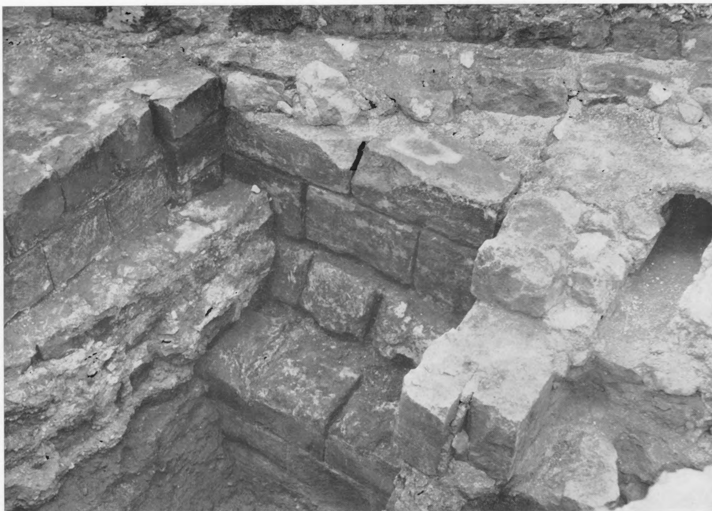
1. Détail de la face Sud du donjon.
