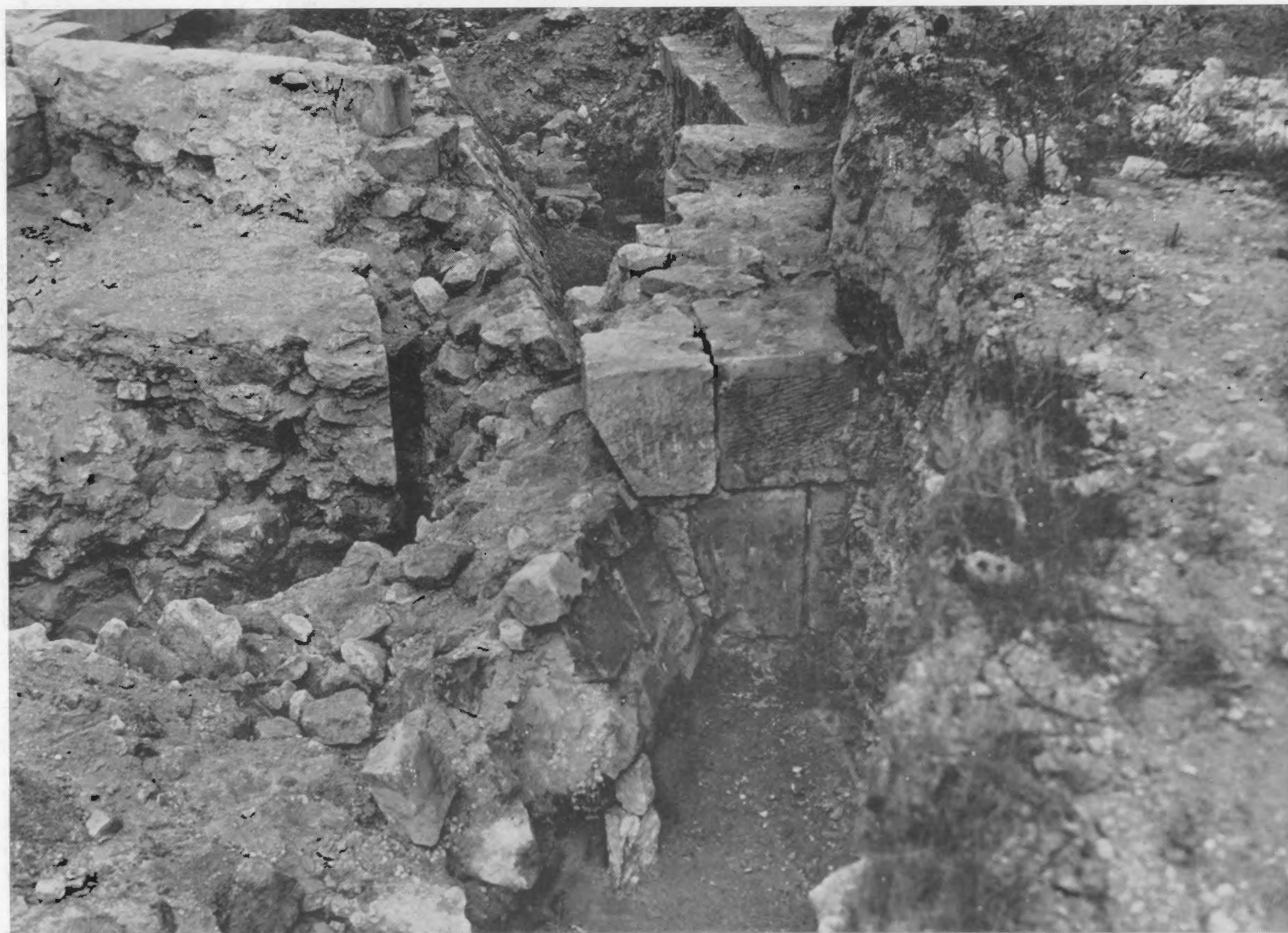
2. Pointe saillante du bloc de fondation du contrefort VII.
