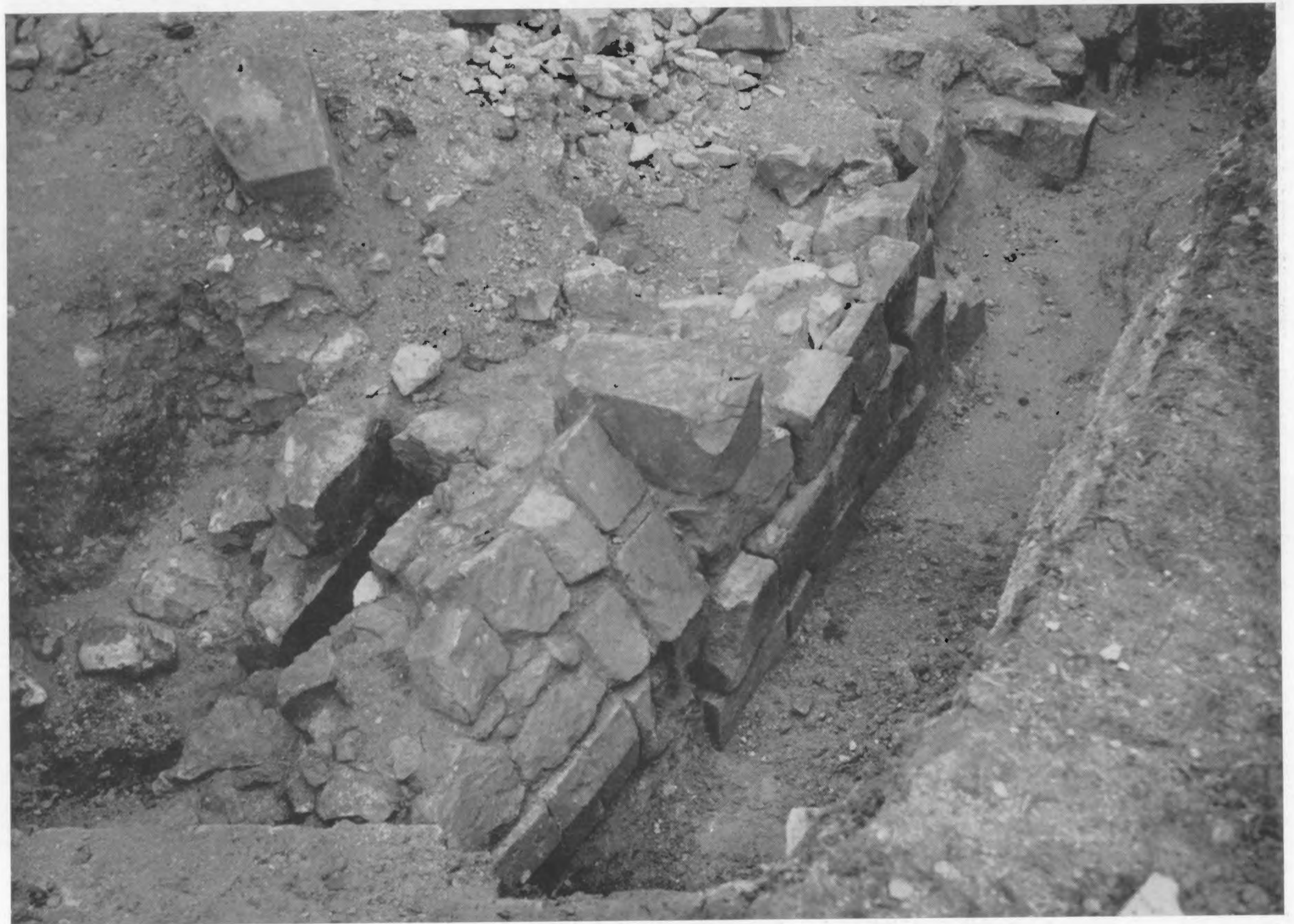
2. Reste du mur sud de l'avant-corps.
