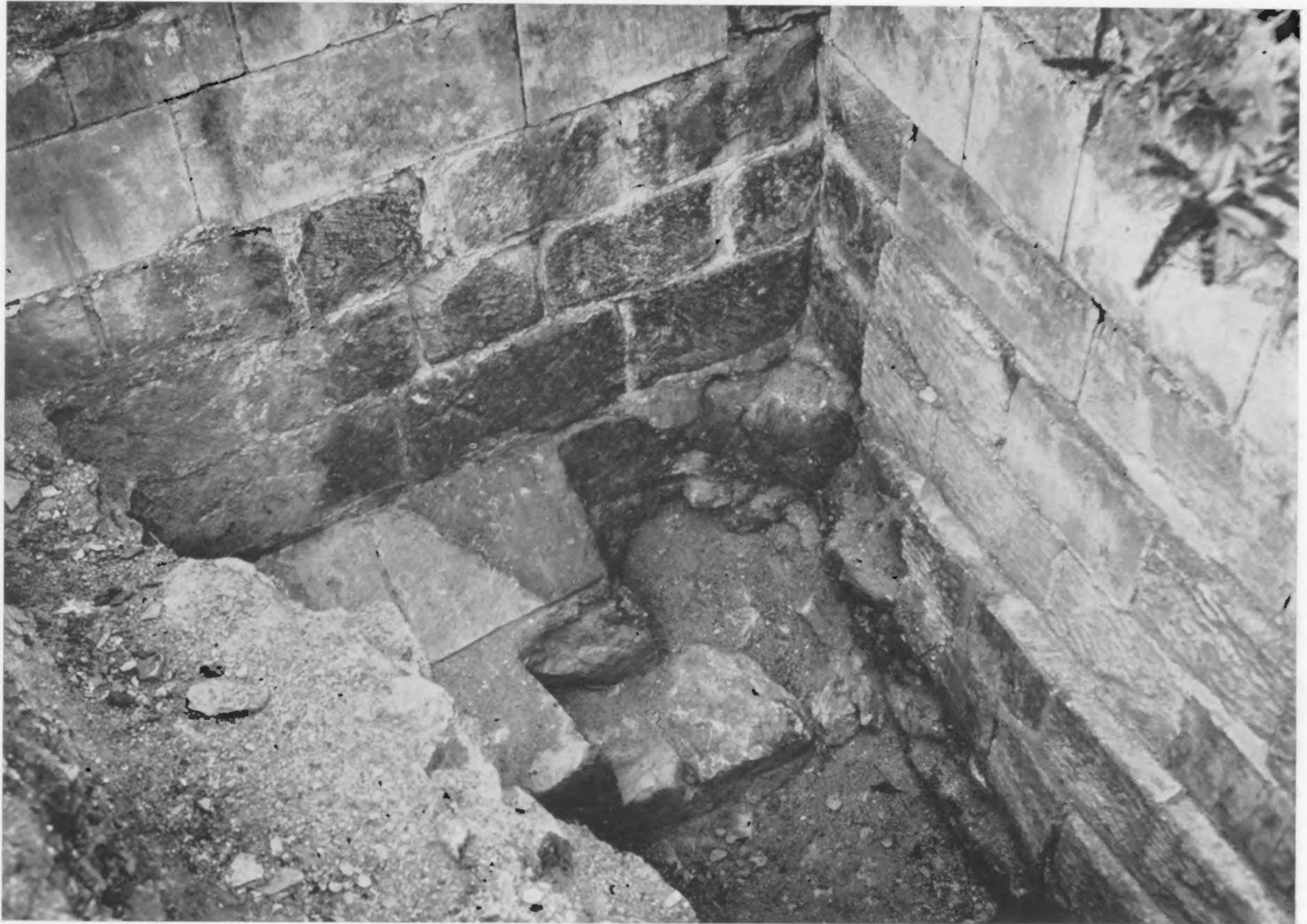
1. La face Sud du contrefort IV (à droite).
