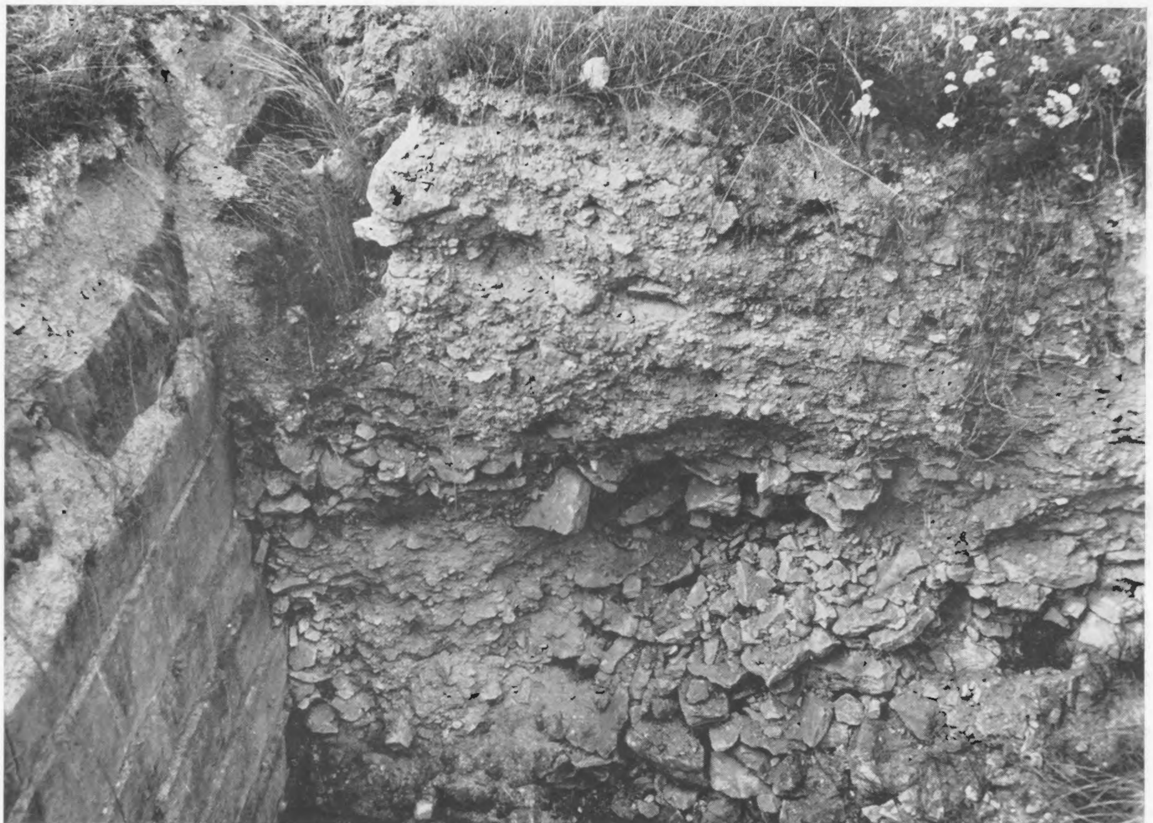
2. La face Nord du contrefort II et l'entaille dans le paquet de remblai.
