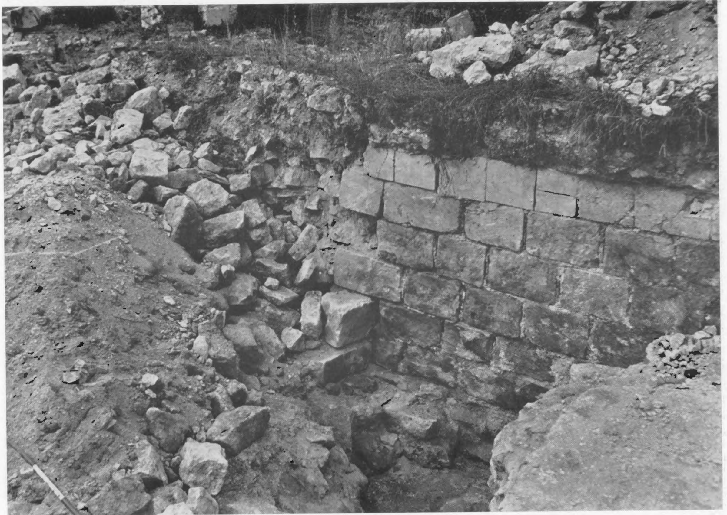
1. La partie du mur Sud, restée intacte derrière le contrefort VII.
