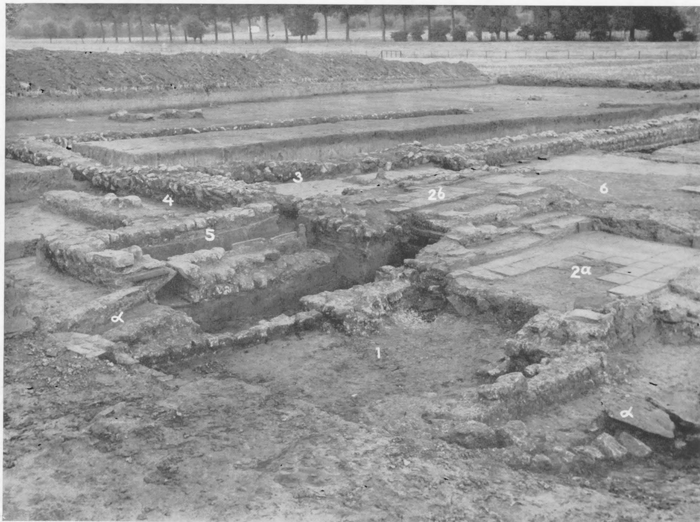
Een gedeelte van het badgebouw.
