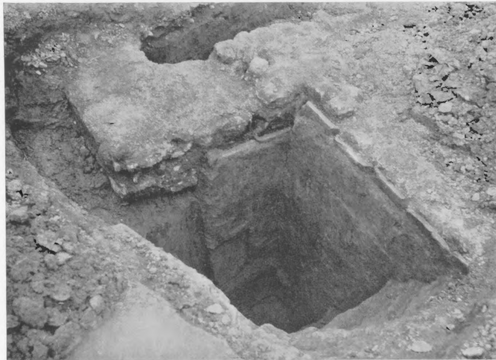
3. De buitenhoek van de kelder.
