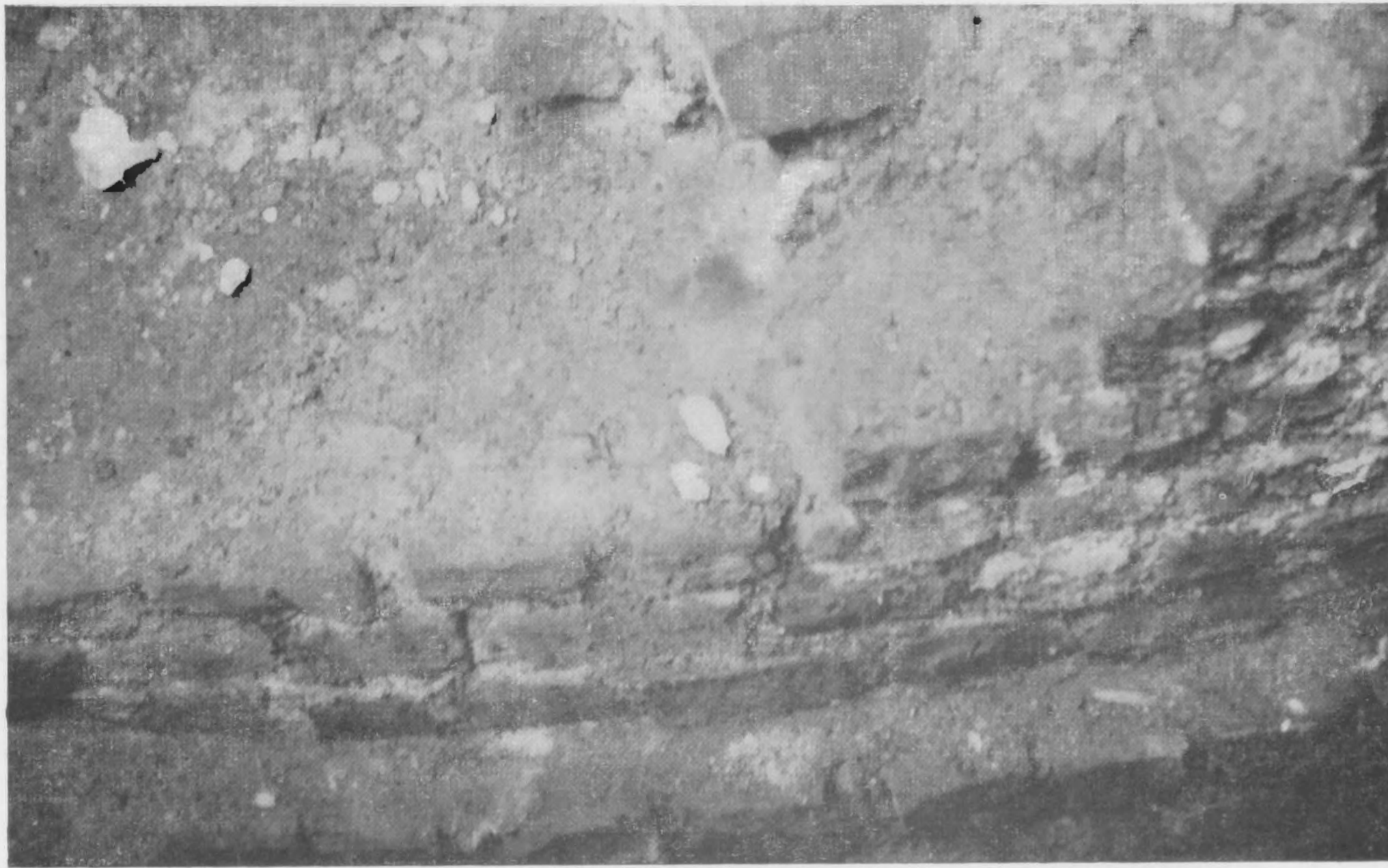
Afb. 12. Kolenzandstenen onderbouw van een Romeinse toren, O.L. Vrouwekerk te Maastricht
