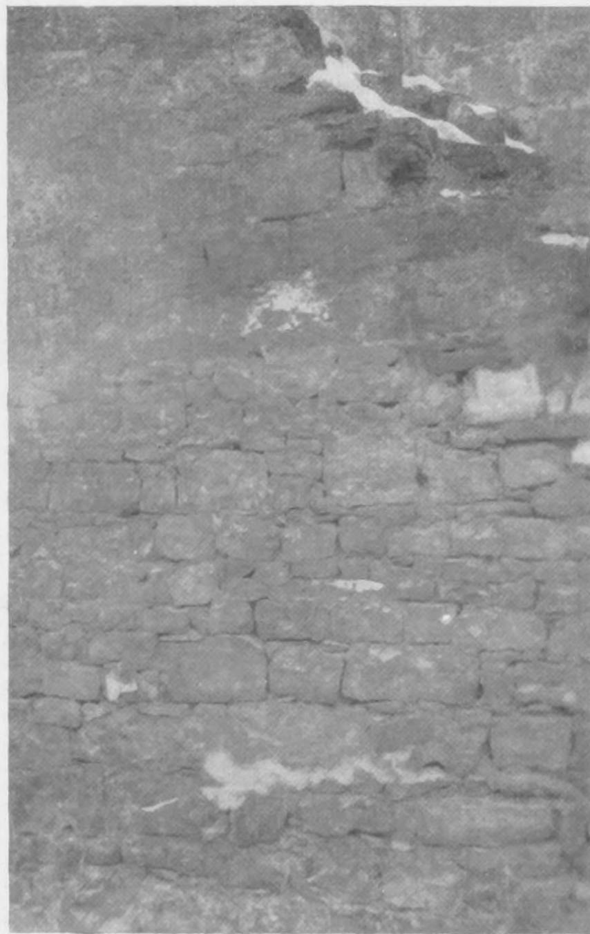
Afb. 19. Muurwerk van de onder No. 18 genoemde toren
