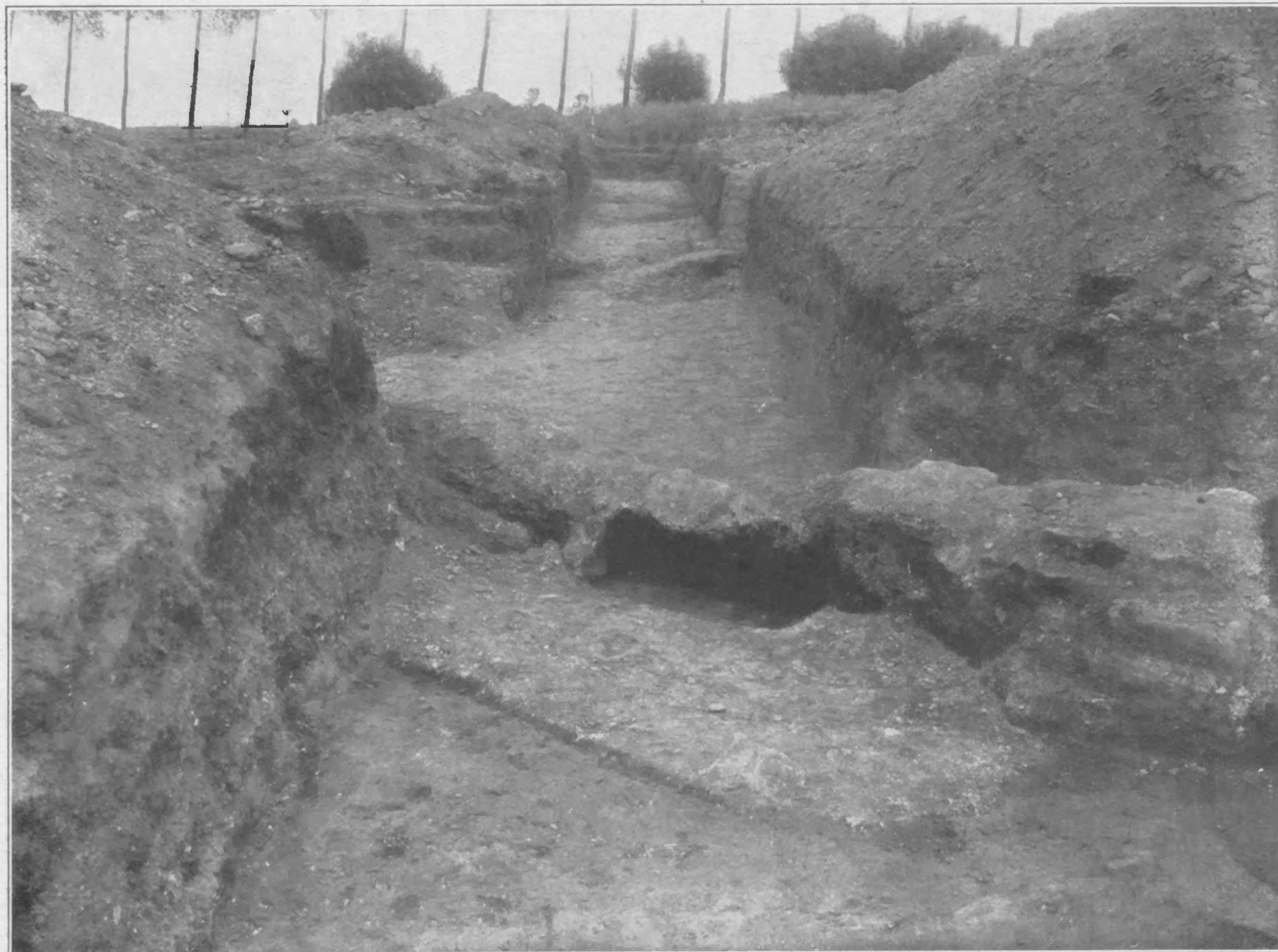
Afb. 6. Fundamenten groote zaal.
