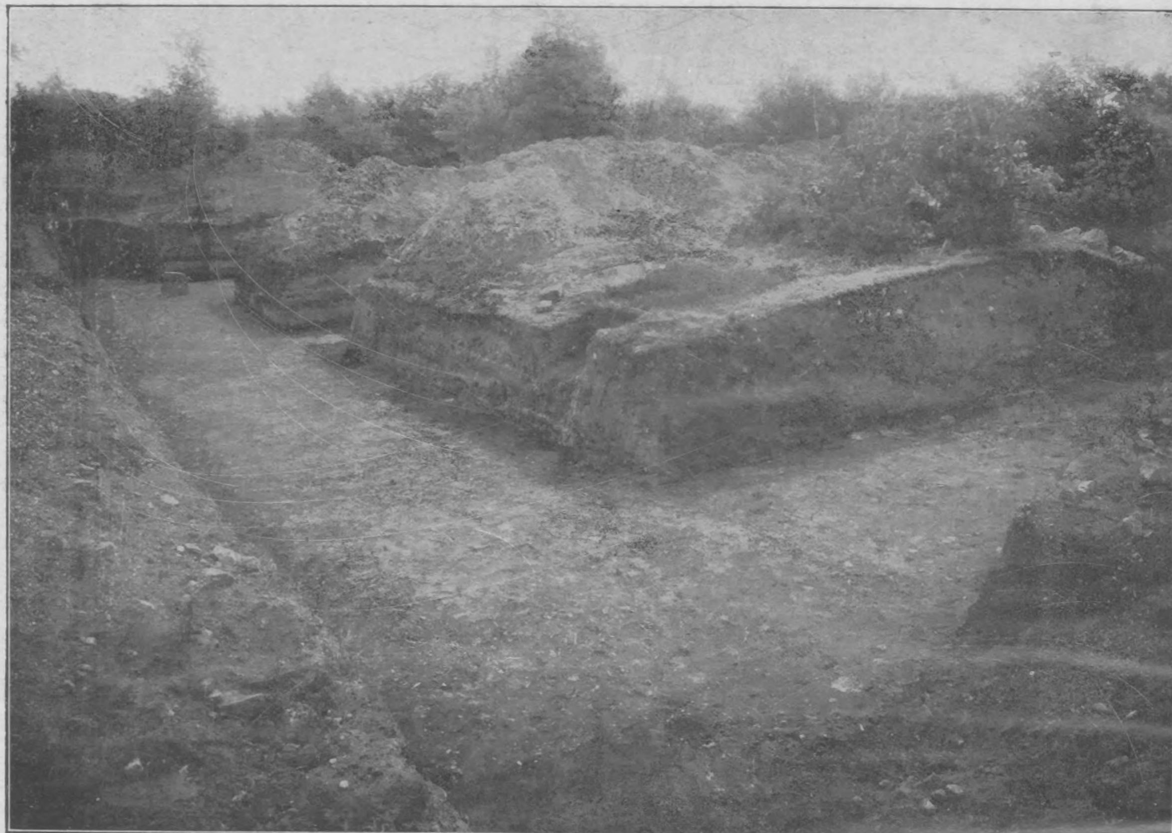
1. Fundamenten van den woontoren in den Hunenborg.
