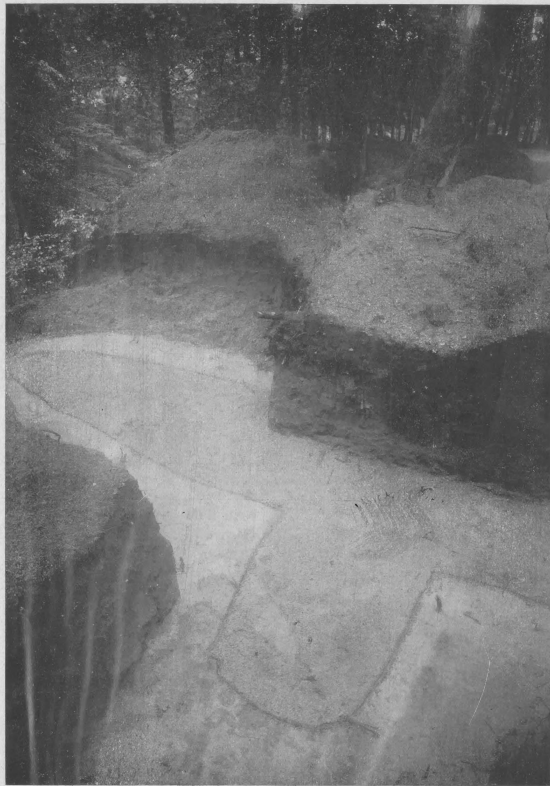
De palissadegreppel aan den ingang van Montferland.
