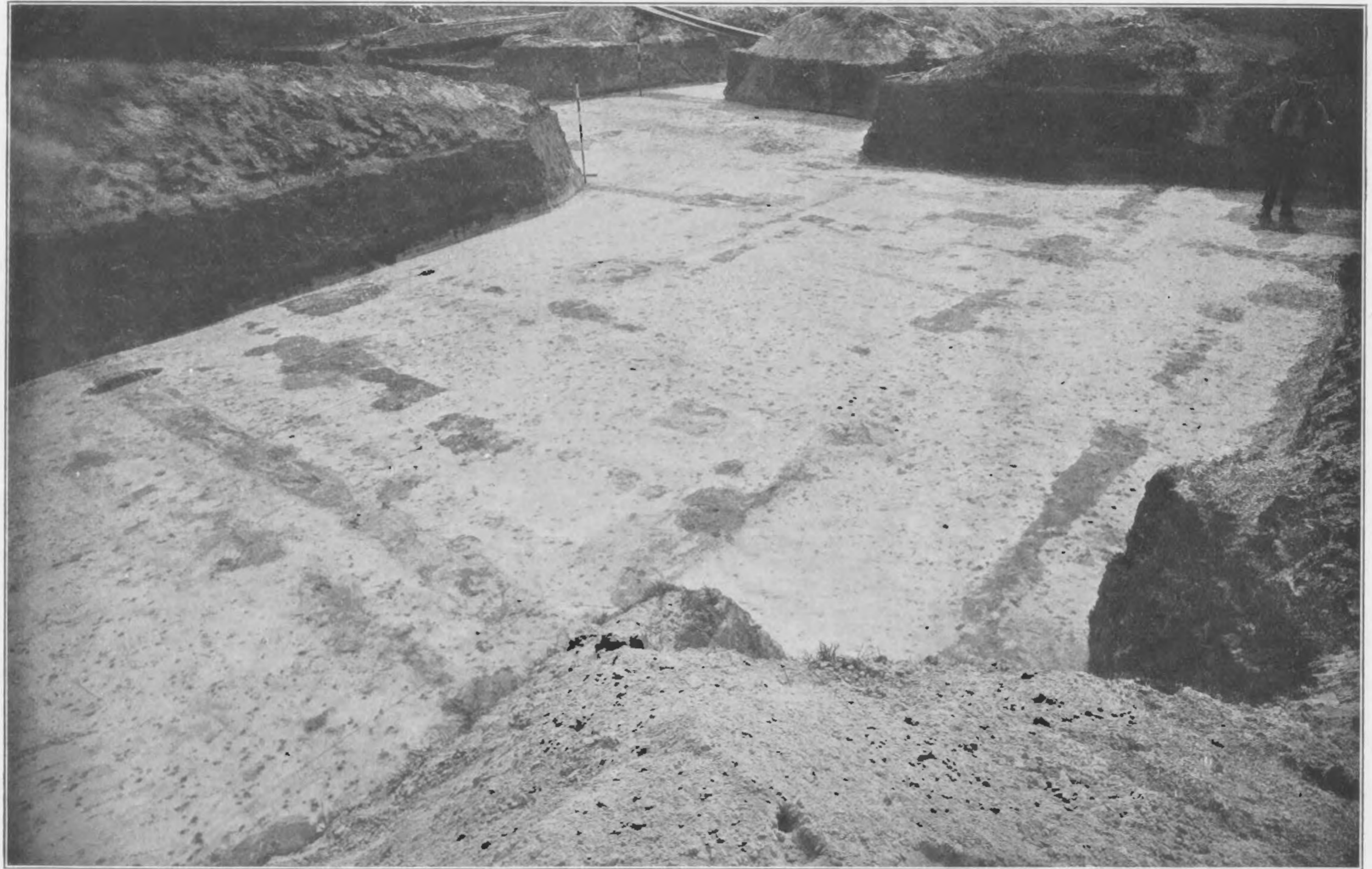
Afb. 6. De N. W. hoek der Kazernegebouwen.
