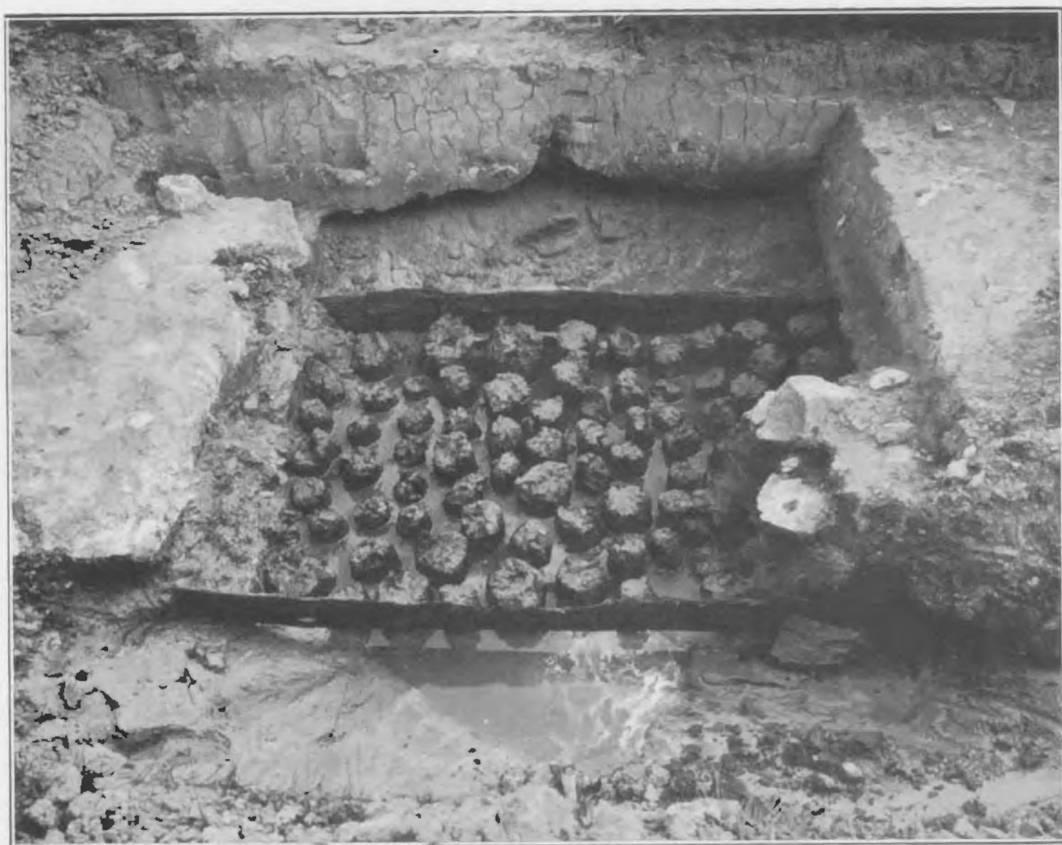
Afb. 24. Heipalen en schoeïng onder den muur.
