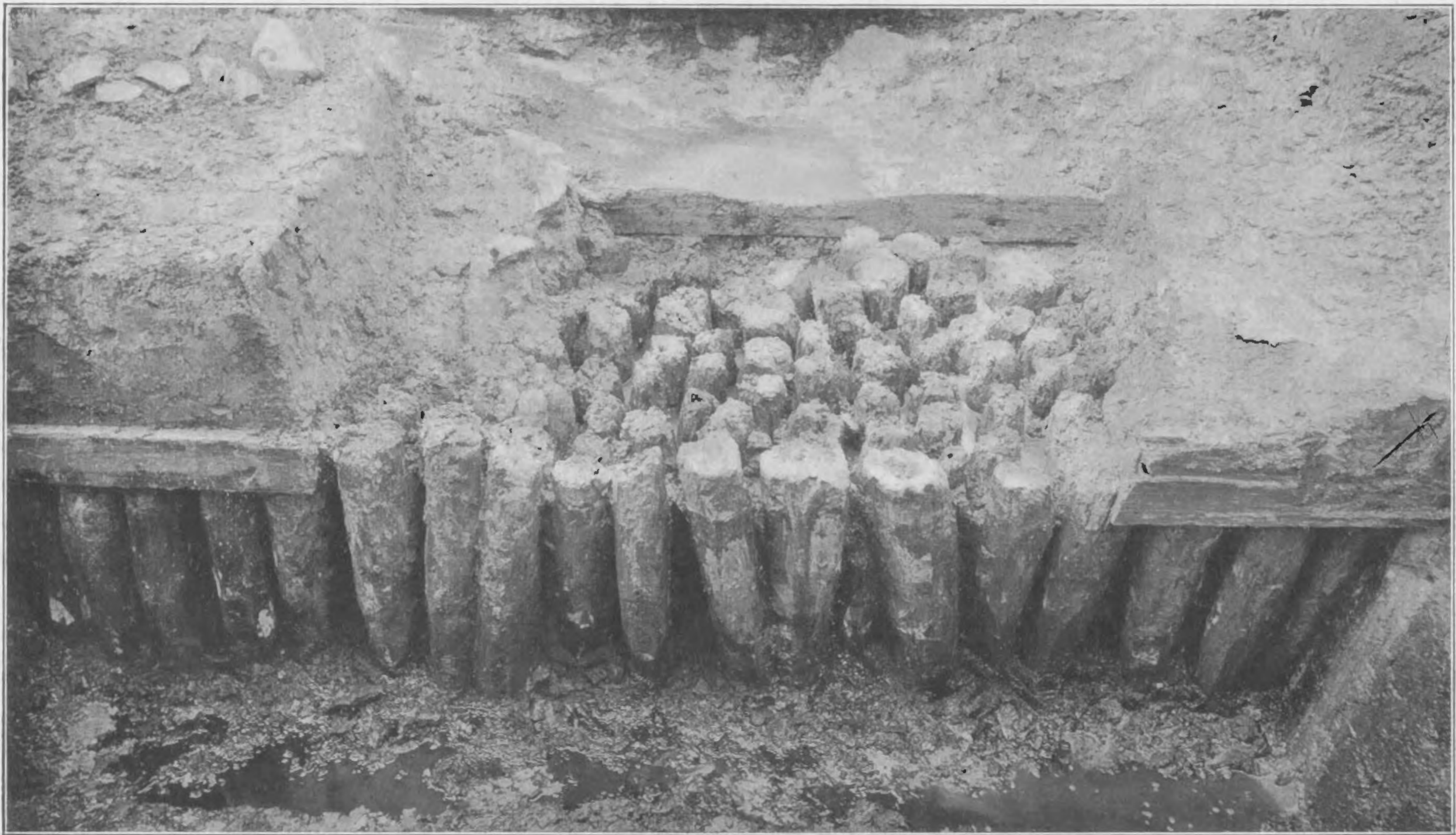
Afb. 26. Heipalen onder den muur tot op hun diepte uitgegraven.
