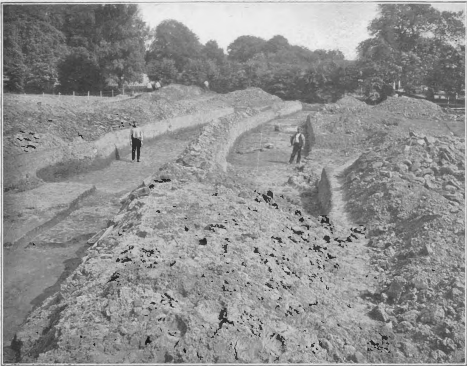
Afb. 29. De uitgegraven waterbedding op het achterterrein.
