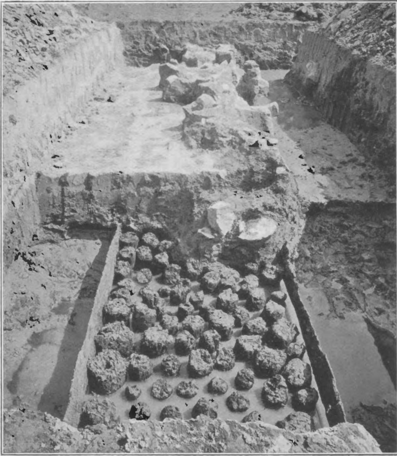
Afb. 25. Heipalen en schoeïng onder den muur.
