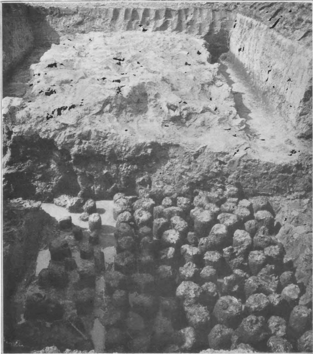
Afb. 27. Het verbrede muurfundament met zijn heipalen.
