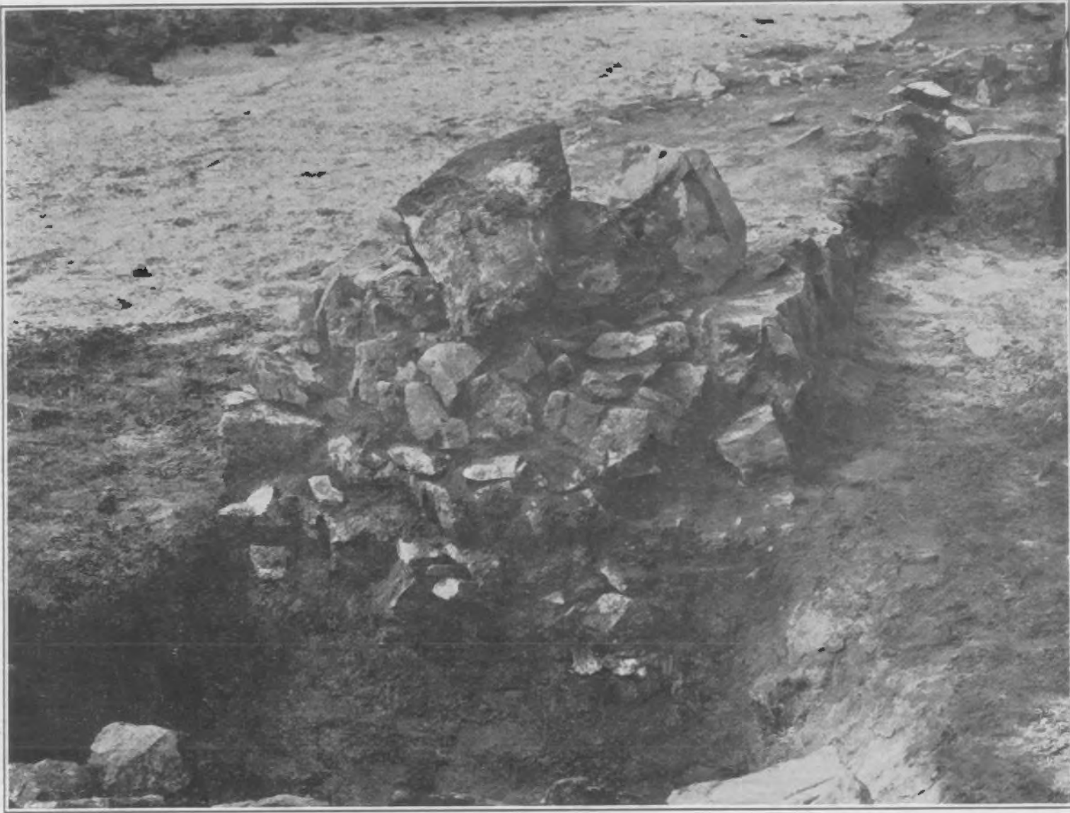
Afb. 32. Opgebroken muurfundament (Contrefort rechts achteraan).
