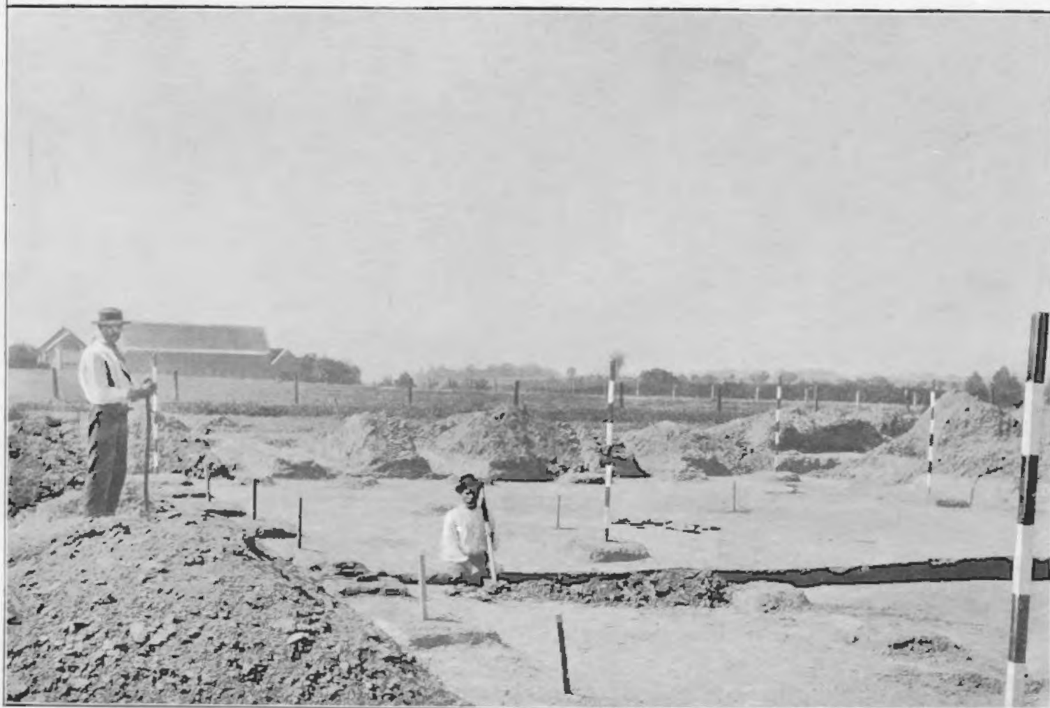
Pl. III. Romeinsche hoeve Valkenburg: 1. Kiezelfundament van het groote gebouw ( a ) en afvalsgat ( b ), gezien van het N.W.; 2. dezelfde fundamenten van het N.O. gezien.
